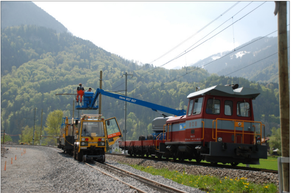
Unten: Fahrleitungsbau in der Oberei.
